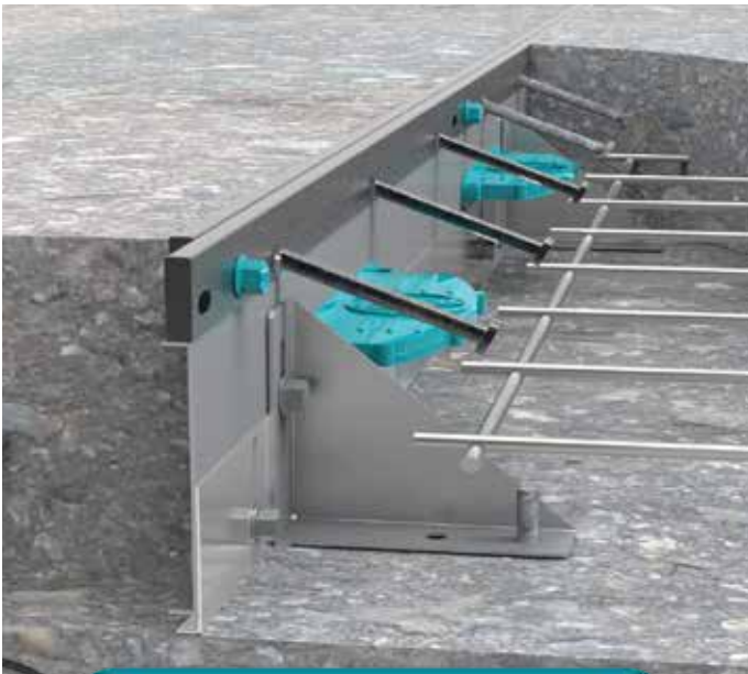
BETON DÖKÜMÜNDEN HEMEN SONRA
